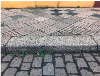
Oben: Granitbordstein im »Wormser Format« in der Zornstraße. Rechts: Wandler in der Mitte der Krypta.
